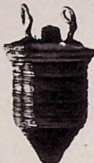
Bild 4. Beispiel einer für Hf-Felder bestimmten Suchspule vor dem Einbau in den Sondenkörper
